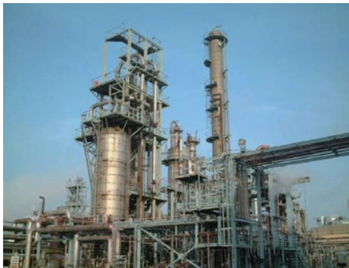
図2 化学工場に見られる巨大タワー [1]
