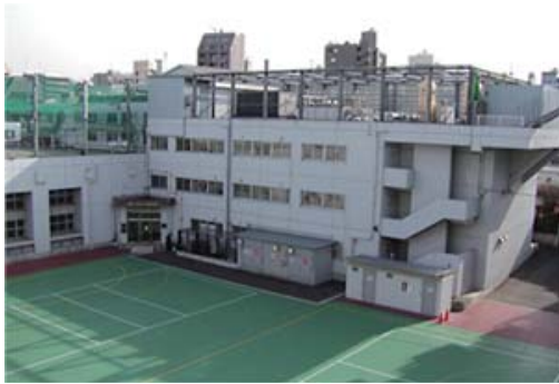
図3 NTRC 建屋の外観
