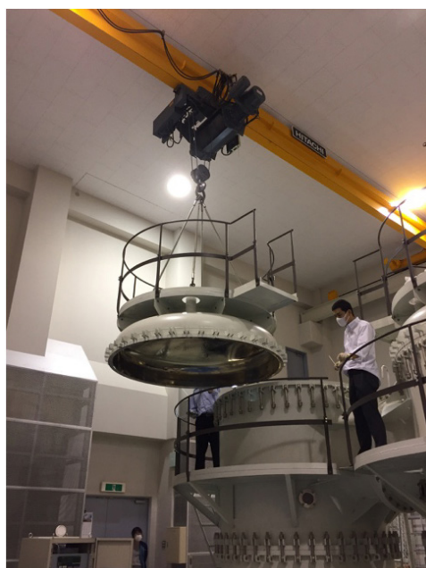
図9 装置の保守・修理の場景
